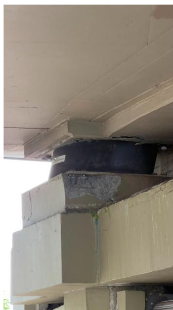
(b) Calle 13 bridge
