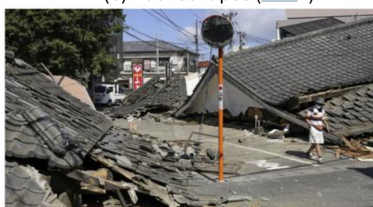
(d) complete collapse of building ( Link 71 )
