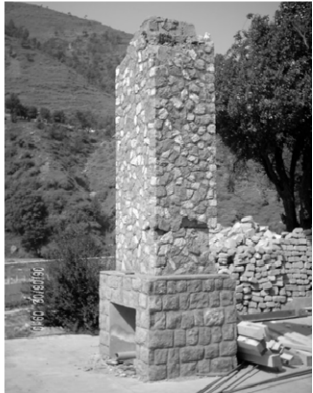
b). A fireplace chimney.
