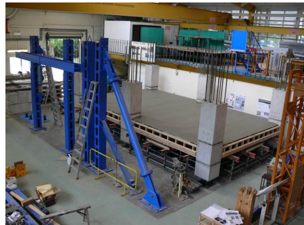
(b) First floor in-situ topping pour complete.
